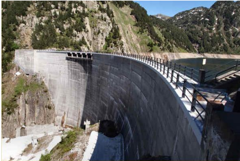
Figure 17 : Photographie du barrage de Naguille (aménagement hydroélectrique des Forges d'Orlu)
