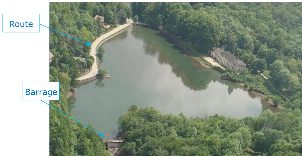
Figure 16 : Retenue et barrage de Campauleil (aménagement hydroélectrique Le Teich)
